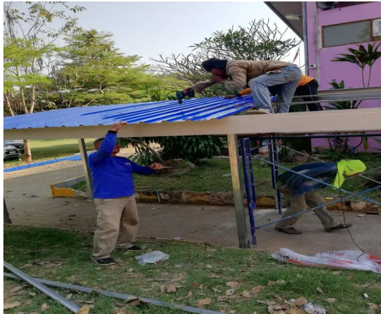
ผู้นำชุมชนและผู้ปกครองให้ความร่วมมือ มีจิตอาสาช่วยมุงหลังคาทางเดินไปห้องน้ำนักเรียนของ โรงเรียนบ้านโคกนางามปลาเซียมอัมพวัน
